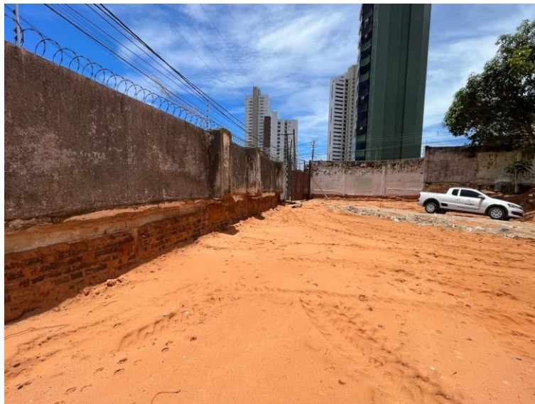
Figura 2: escavação de solo.
