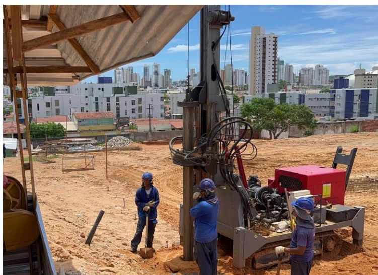
Figura 5: execução de estaca escavada.
