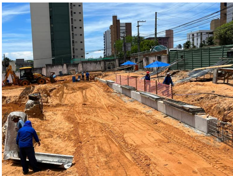
Figura 4: viga de coroamento das estacas.
