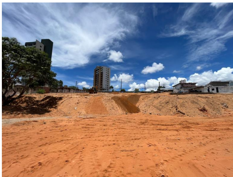
Figura 1: escavação de solo
