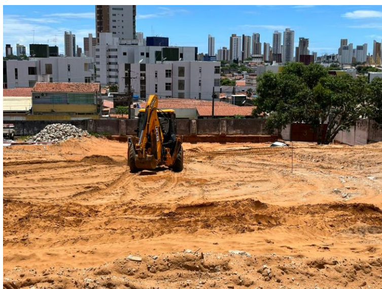
Figura 3: escavação de solo.
